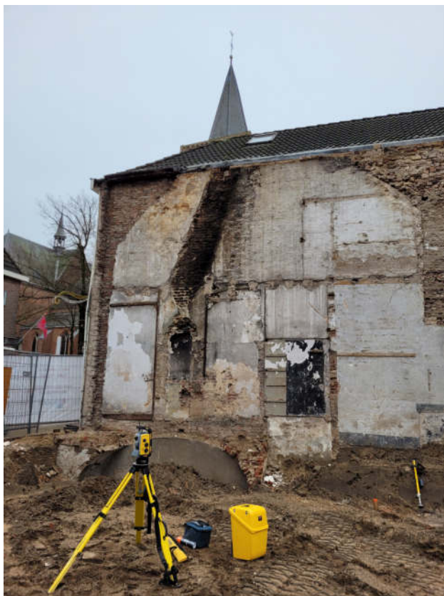
Terrein gezien richting het zuiden met op de achtergrond de Oude kerk. De kelder is aan de voorzijde van het terrein nog zichtbaar.
