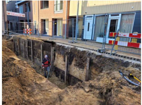
Het plaatsen van de damwand aan de noordzijde langs de Brouwershoef.
